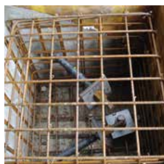
Standardfundament mit Holzschalung und Armierung Standard foundation with wooden casing and reinforcement
