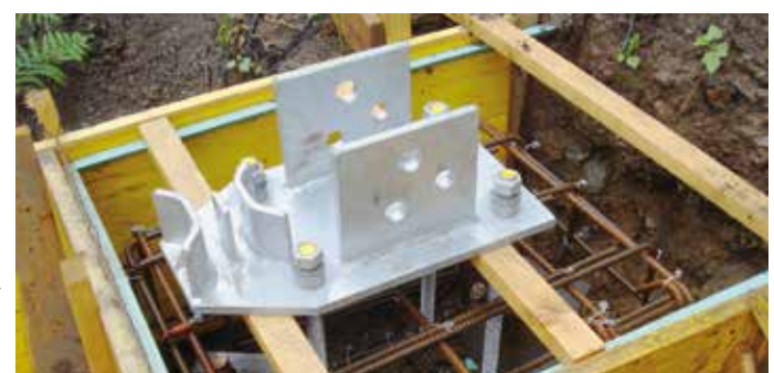
Montierte Bodenplatte auf vorbereiteter Schalung Mounted ground plate on assembled casing
