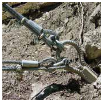
Feuerverzinkter „Omega“ Ankerkopf Hot dip galvanised „Omega“ anchor head
